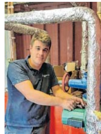
Installation: Brauns Sohn Patrick bei der Arbeit.
